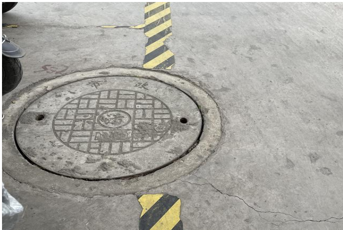
生活污水总排口
