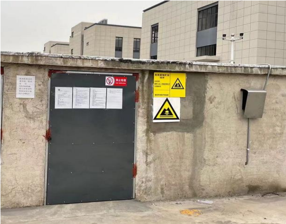
图4-6 项目固废处置设施相关照片
